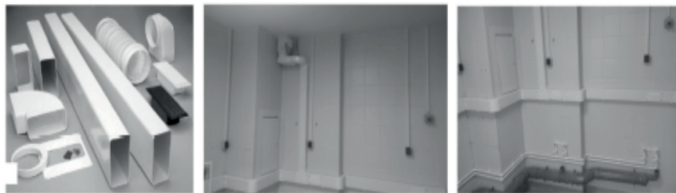
Рис. 8 Образец вытяжных коробов с решетками
